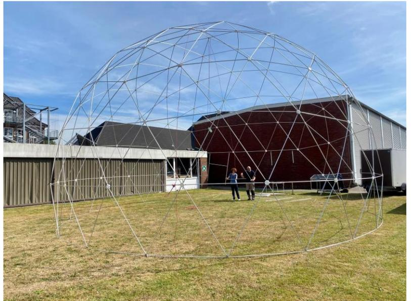
Bereits einen Tag vor den Aufführungen wurde das Planetarium mit seinen 10 m Durchmesser aufgebaut. Stück für Stück entstand aus Zeltstangen die geodätische Kuppel, die anschließend mit drei Schichten Stoff bespannt wurde. Danach wurden für 60 Personen wurden Sitzplätze bereitgestellt. Zum Glück war es die während der gesamten Zeit relativ windstill, denn die Kuppel ist nicht für den Außeneinsatz bei Wind gedacht.
